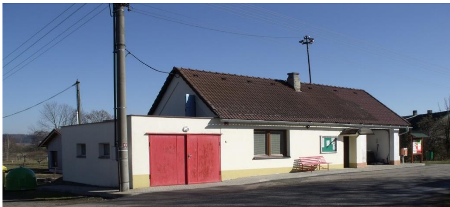
Stávající víceúčelový objekt v Dolních Černůtkách
